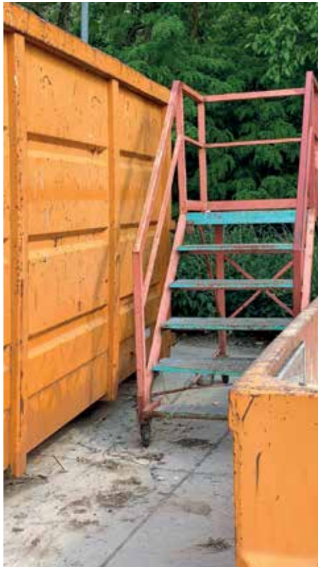
Die wackelige Leiter ist obendrein viel zu niedrig für diesen Container.
